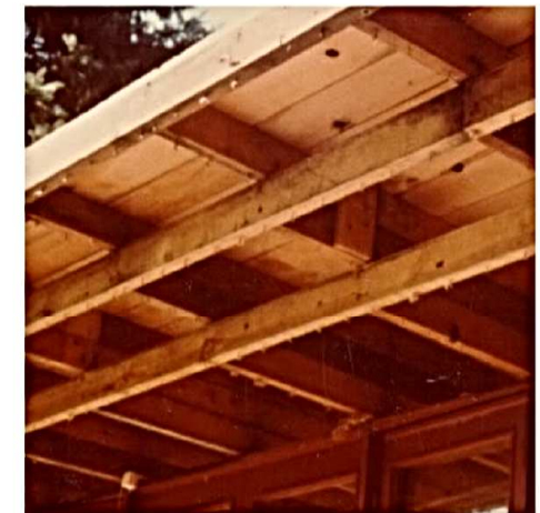
Toiture en rénovation, vue sur la charpente.
