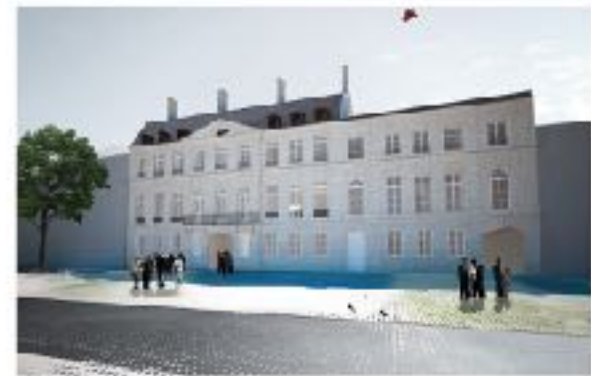
1. La façade restaurée de l'Hôtel de Biolley, au Nord.
